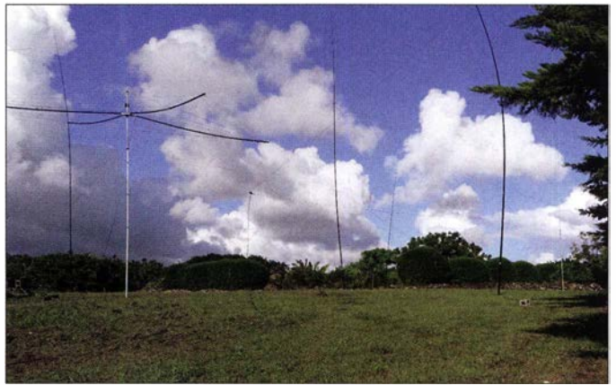
Antennenanlage mit Spiderbeam und Vertikalstrahlern
